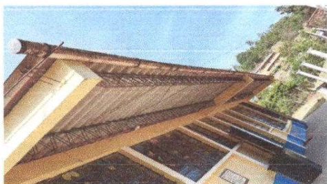
Foto 3: Sustitución de canal de pvc tipo colonial
