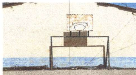
Foto 4: Pintura en muros exteriores e interiores
